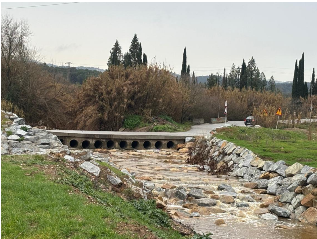
OBRA RIERA SANT CUGAT La imatge superior mostra el punt on es troba el llavi d'entrada a la bassa de laminació des de la riera de Sant Cugat en la seva marge dreta. La imatge inferior mostra l'entrada en càrrega de la bassa de laminació en la crescuda de setembre de 2025.
