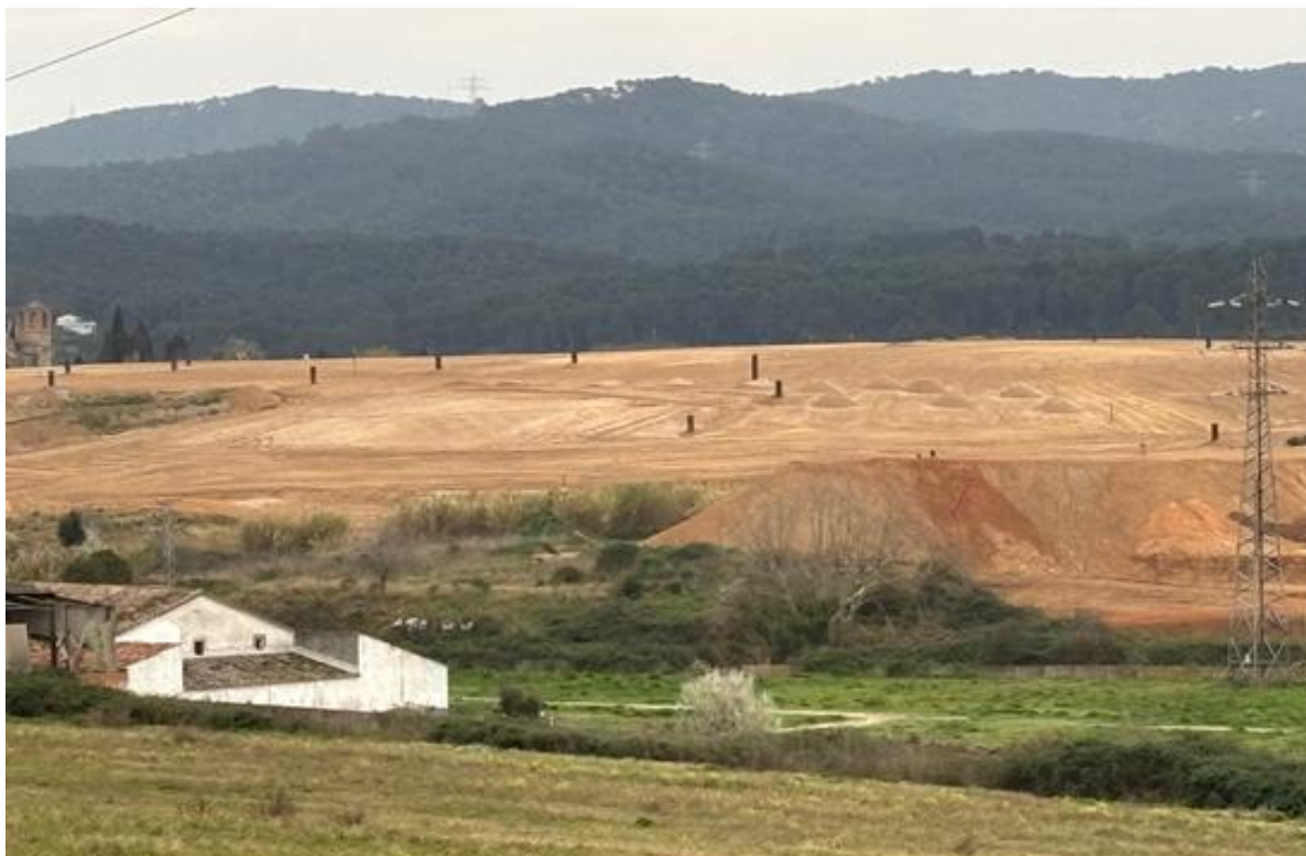
Perspectiva de l'OBRA RESSEGELLAT DE L'ABOCADOR DE CAN PLANAS promoguda per l'AMB. A la imatge de dalt s'observa l'execució de la capa de sorres i gravetes que constitueix la cap drenant de pluvials i protectora de la capa d'argiles. A la imatge inferior s'observa la col·locació del geotèxtil entre les capes drenants.
