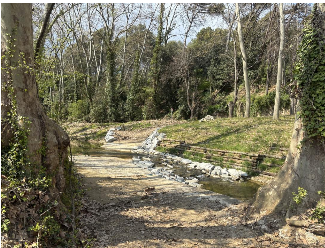
OBRA RIERA SANT CUGAT Imatge de dalt es una visió hivernal del gual de can Costa per on passa la canonada de residuals de la urbanització del sector de Can Costa (projecte H1). Les actuacions realitzades apliquen tècniques de bioenginyeria, en aquest cas entramat viu i escullera vegetada. Imatge inferior visió primaveral.
