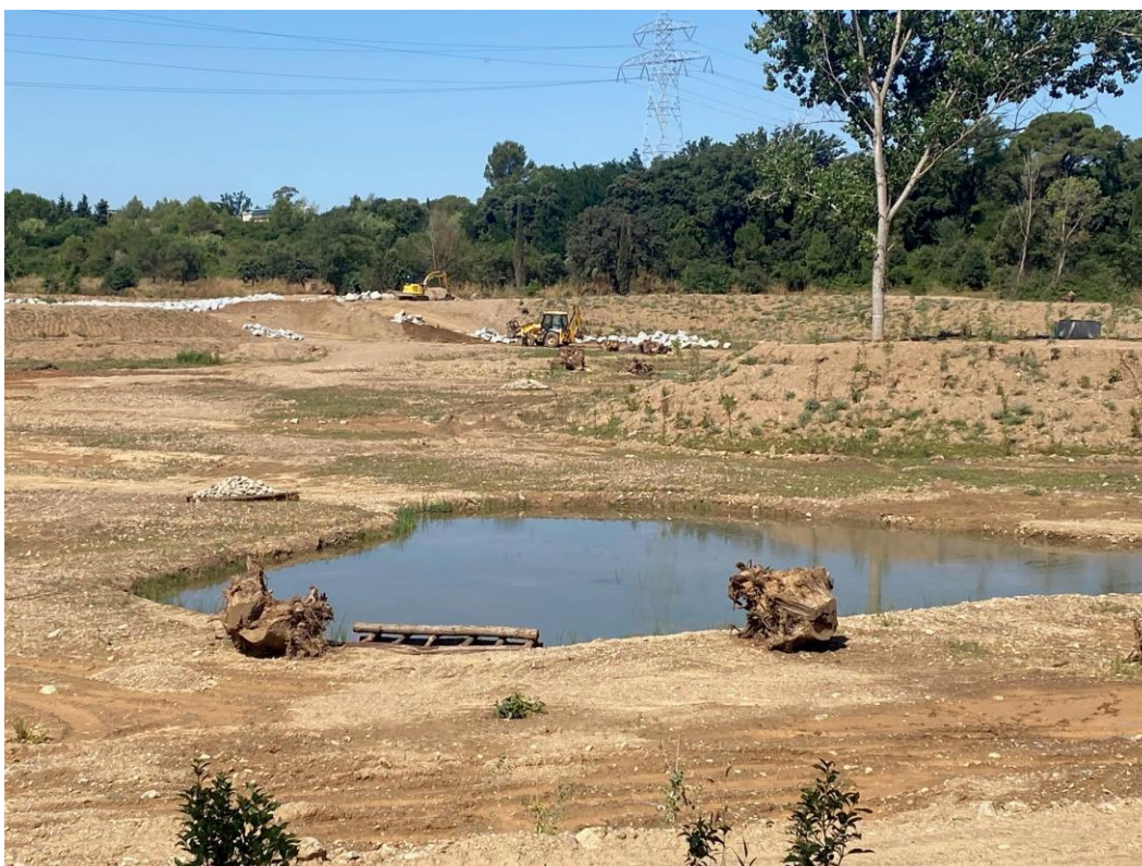
OBRA RIERA SANT CUGAT Bassa de laminació meandre Can Codonyers riera Sant Cugat. Bassa que ha quedat en l'època d'estiatge del 2025 amb aigua disponible per que s'instauri la vegetació helofítica. S'observen les estructures per refugi de fauna: vedrunes amb pedra per rèptils, soques per insectes pol·linitzadors i saproxílics i petits mamífers i entramats de fusta per amfibis.
