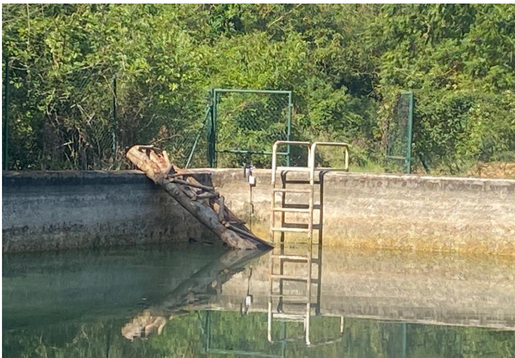
OBRA RIERA SANT CUGAT Rampa per facilitar la sortida de fauna petita que pugui quedar atrapada a la bassa de reg. Aquest antiga bassa de la finca de Can Costa s'omple amb aigua de pou i es fa servir pel manteniment de les plantacions de l'obra de restauració de la riera de Sant Cugat.
