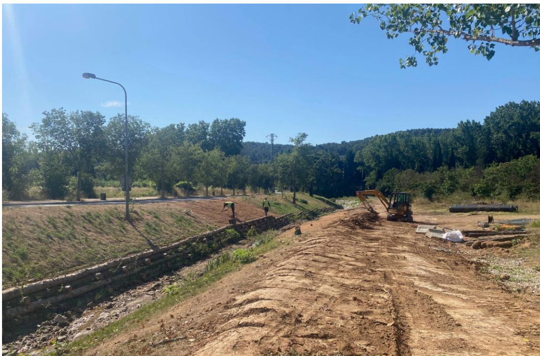
OBRA RIERA SANT CUGAT Perspectiva general de les actuacions amb bioenginyeria realitzades al torrent de Sant Marçal on s'ha reconfigurat la secció longitudinal especialment a la seva desembocadura a la riera de Sant Cugat, també els marges i s'ha aprofitat per retirar tota la canya (Arundo donax) que envaïa la llera.
