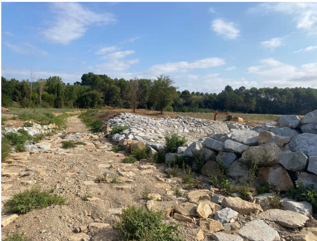
OBRA RIERA SANT CUGAT Imatge superior obres de construcció del llavi d'entrada a la bassa de laminació des de la riera de Sant Cugat. Imatge inferior bassa de desbastament de les aigües que entren a la bassa de laminació en execució.
