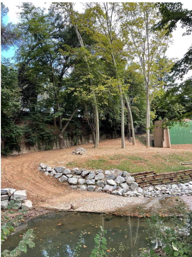
OBRA RIERA SANT CUGAT Gual de can Costa per on passa la canonada de residuals de la urbanització del sector de Can Costa (projecte H1). Les actuacions realitzades apliquen tècniques de bioenginyeria que es poden veure a la imatge de l'esquerra. A la imatge de baix rastres de llúdriga (Lutra lutra) trobades al nou gual al mes de setembre.
