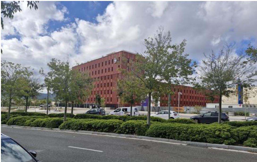
Edifici de residència col·lectiva ja en servei ubicat a la parcel·la PC2*-03.03. Vista des de l'Avinguda de la Ciència.
