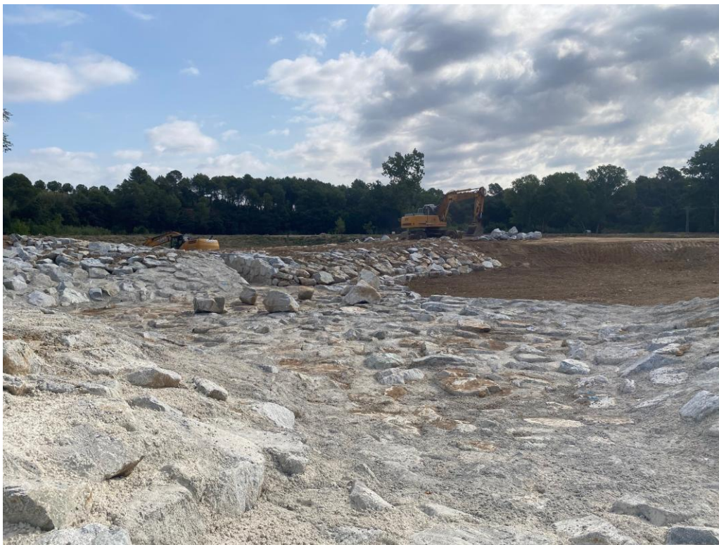
OBRA RIERA SANT CUGAT Imatge superior obres de construcció del llavi d'entrada a la bassa de laminació des de la riera de Sant Cugat. Imatge inferior bassa de desbastament de les aigües que entren a la bassa de laminació en execució.
