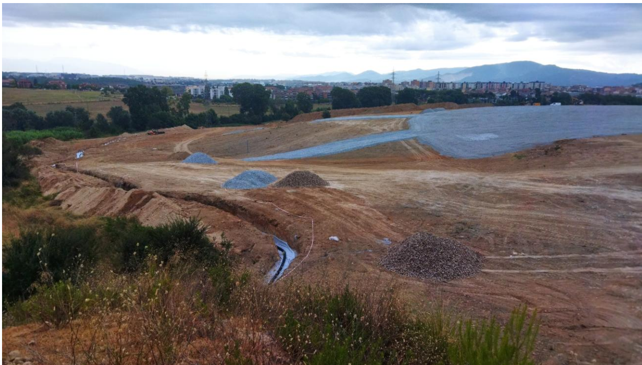
Perspectiva de l'OBRA RESSEGELLAT DE L'ABOCADOR DE CAN PLANAS. S'observa la capa de grava per la sortida controlada dels gasos i el drenatge perimetral de les aigües pluvials.
