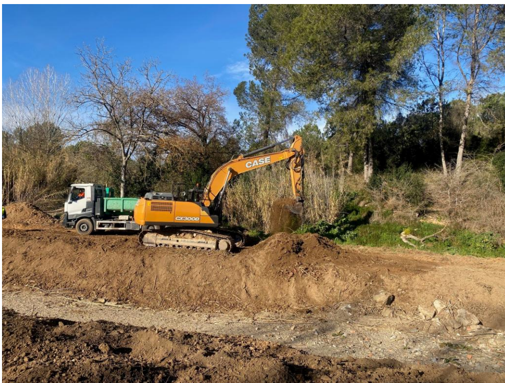
OBRA RIERA SANT CUGAT a dalt desbrossada de canya als marges de la riera, zona futur llavi entrada aigua a la bassa de laminació. A baix cribratge restes de canya prèvia retirada a zona abocament.
