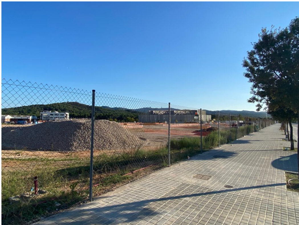
Moviments de terres al centre de processament de dades promogut per AQ Compute a la parcel·la PC1-M-07 ubicada a l'entorn del dipòsit controlat de residus Elena.
