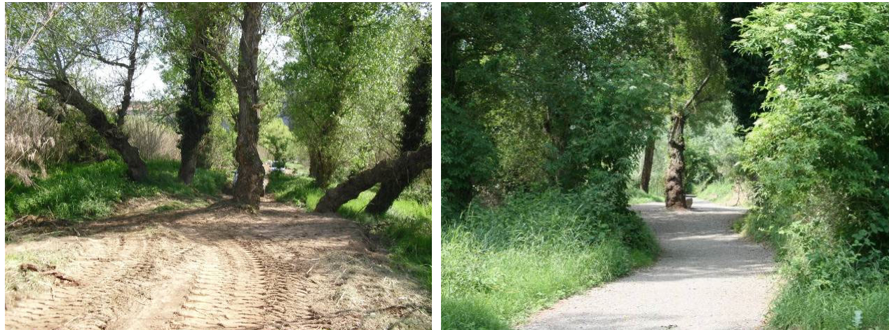
Figura 9 Exemple de camí amb Tot-ú (fotos d'abans i després)
