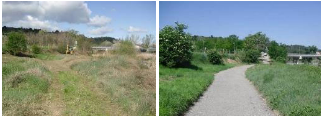
Figura 10 Exemple de camí amb Tot-ú (fotos d'abans i després)
