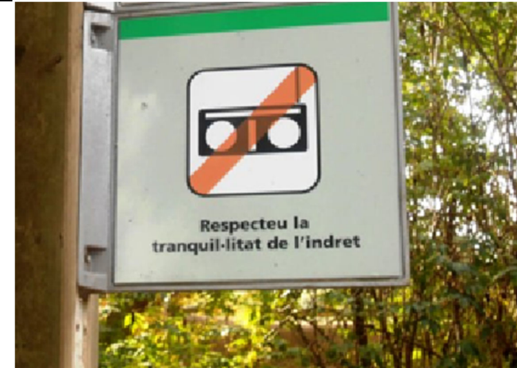
Figura 13 Placa d'avisos cívics format per joc de dues planxes d'alumini de 240x240mm amb impressió directe i vernís protector de poliester curat a 180°, enganxades sobre suport de fosa d'alumini. Suport format per peu dret de fusta de pi amb tractament anticorrosiu de sals metàl·liques (basilit CFK) per immersió i autoclau sistema de buit pressió de 3000x140x140mm. Fixació al terreny amb dau de formigó de 400x400x400mm. Model del Parc de Collserola.
