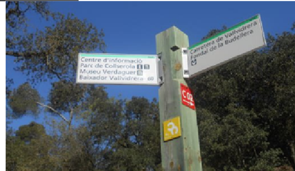
Figura 14 Banderola indicador camins i corriols amb 1, 2 o 3 plaques. Cad a placa està formada pel joc de dues planxes d'alumini de 440x190mm amb impressió directe i vernís protector de poliester curat a 180°, enganxades sobre suport de fosa d'alumini. Suport format per peu dret de fusta de pi amb tractament anticorrosiu de sals metàl·liques (basilit CFK) per immersió i autoclau sistema de buit pressió de 3000x140x140mm. Fixació al terreny amb dau de formigó de 400x400x400mm. Model del Parc de Collserola.
