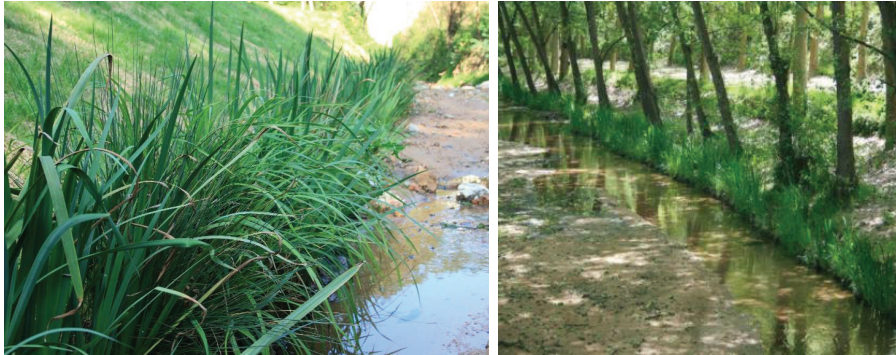
Figura 12 Exemples de rolls vegetatitzats instal·lats
