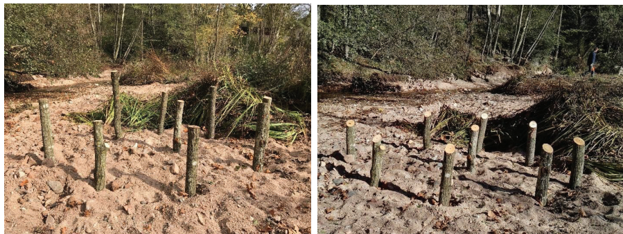
Figura 11 Exemple de raspalls amb estaques executats per Naturalea
