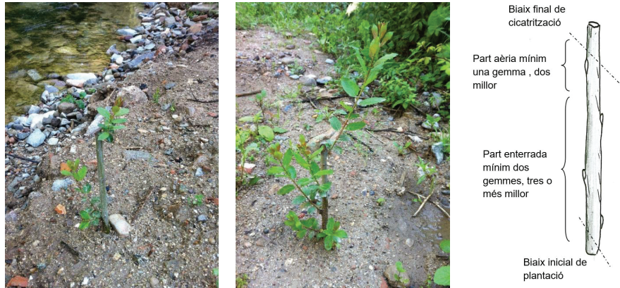
Figura 1 Imatges i esquema d'estaques en espai fluvial
