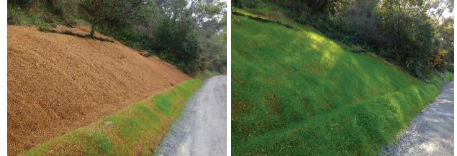
Figura 15 Procés evolutiu d'un talús amb ret de coco executat per Naturalea
