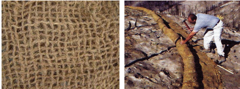
Figura 17 Imatge de detall de la fibra de coco que constitueix els rolls d'escorrentiu (esquerre) i col·locació d'aquests (dreta).
