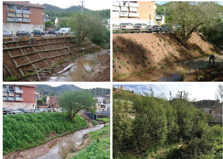
Figura 14 Procés evolutiu d'un enreixat executat per Naturalea
