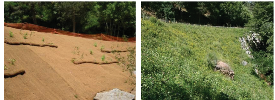
Figura 16 Imatges de rolls per al control de l'escorrentiu col·locats per Naturalea
