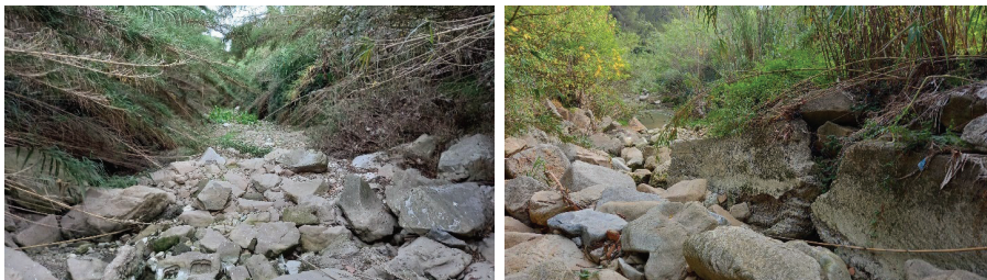
Figura 7 Diversos trams de llera escullerada a la zona 1 Meandre
