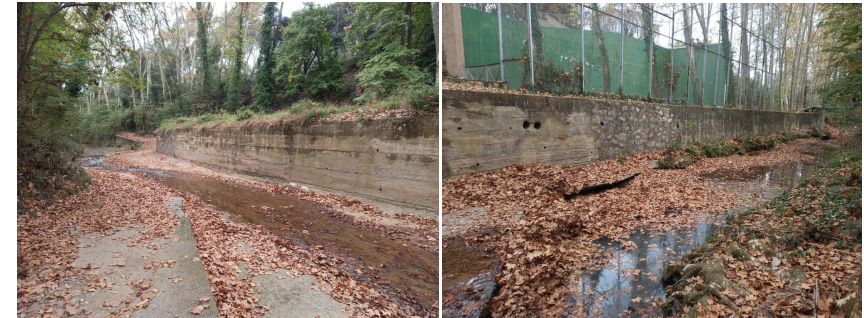
Figura 8. Imatges de les estructures a retirar a la zona del gual de Can Costa
