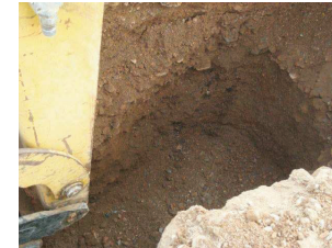
04- Detall de l'interior de la cala C2
