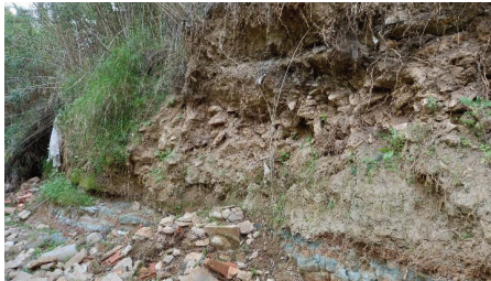
Figura 2 Reblerts antròpics amb restes de runa.
