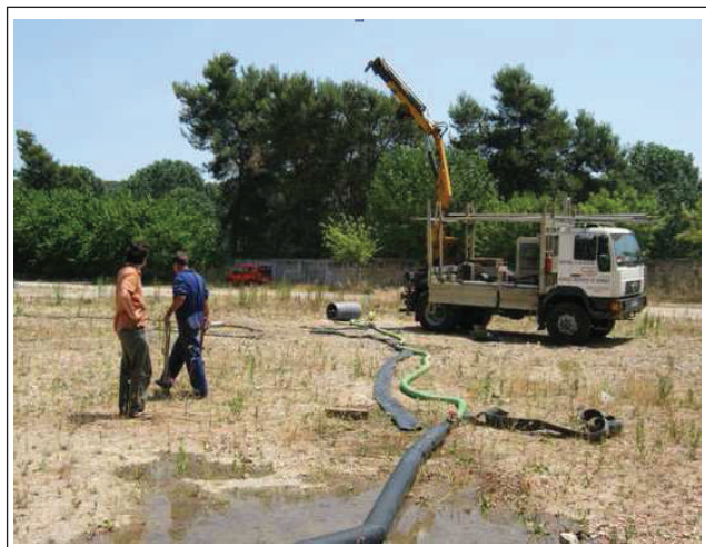
Foto 1: Instal·lació de la bomba per l'assaig a Distri-Vallès.
