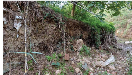
Figura 3 Reblerts antròpics amb restes de runa.
