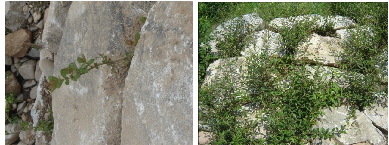
Figura 1 Detall d'escullera vegetada
