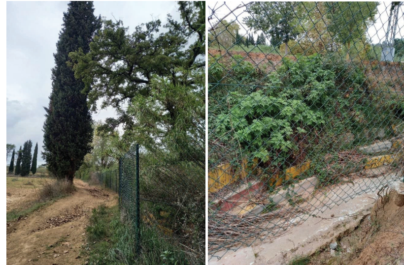
Figura 19 Fotografies de l'estat actual de la Zona 9. Torrent de Sant Marçal
