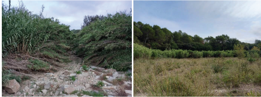
Figura 11 Fotografies de l'estat actual de la Zona 1. Meandre. S'observen els marges envaïts per la canya ( Arundo Donax ), la presència d'escullera, i el meandre amb restes de fonamentacions i amb símptomes de compactació.
