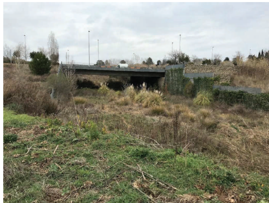
Viaducte de la BP-1413 al seu pas pel Torrent innominat 1 on s'hi troba el punt de connexió a residuals.
