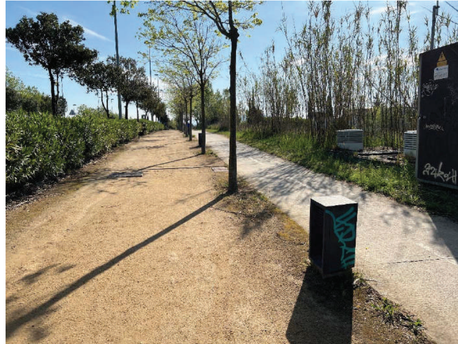
Afectació vorera i carril bici existent
