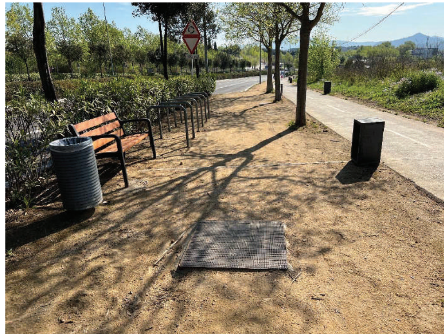
Afectació Mobiliari Urbà i Xarxa reg Impulsió
