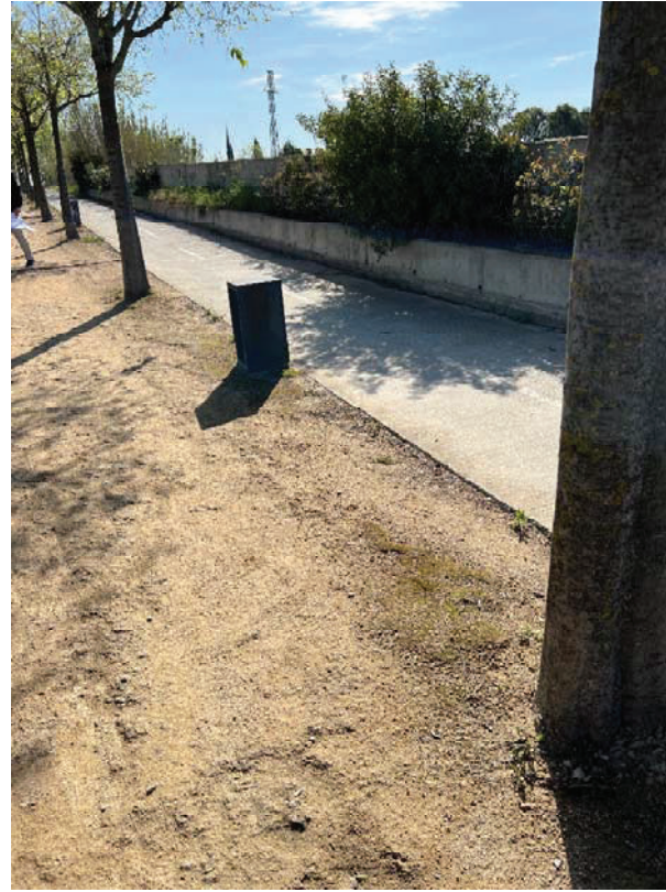
Afectació arbrat i enllumenat carril bici
