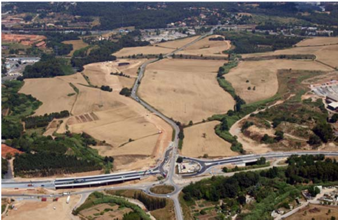
Vista general del Corredor Verd del Parc de l'Alba
