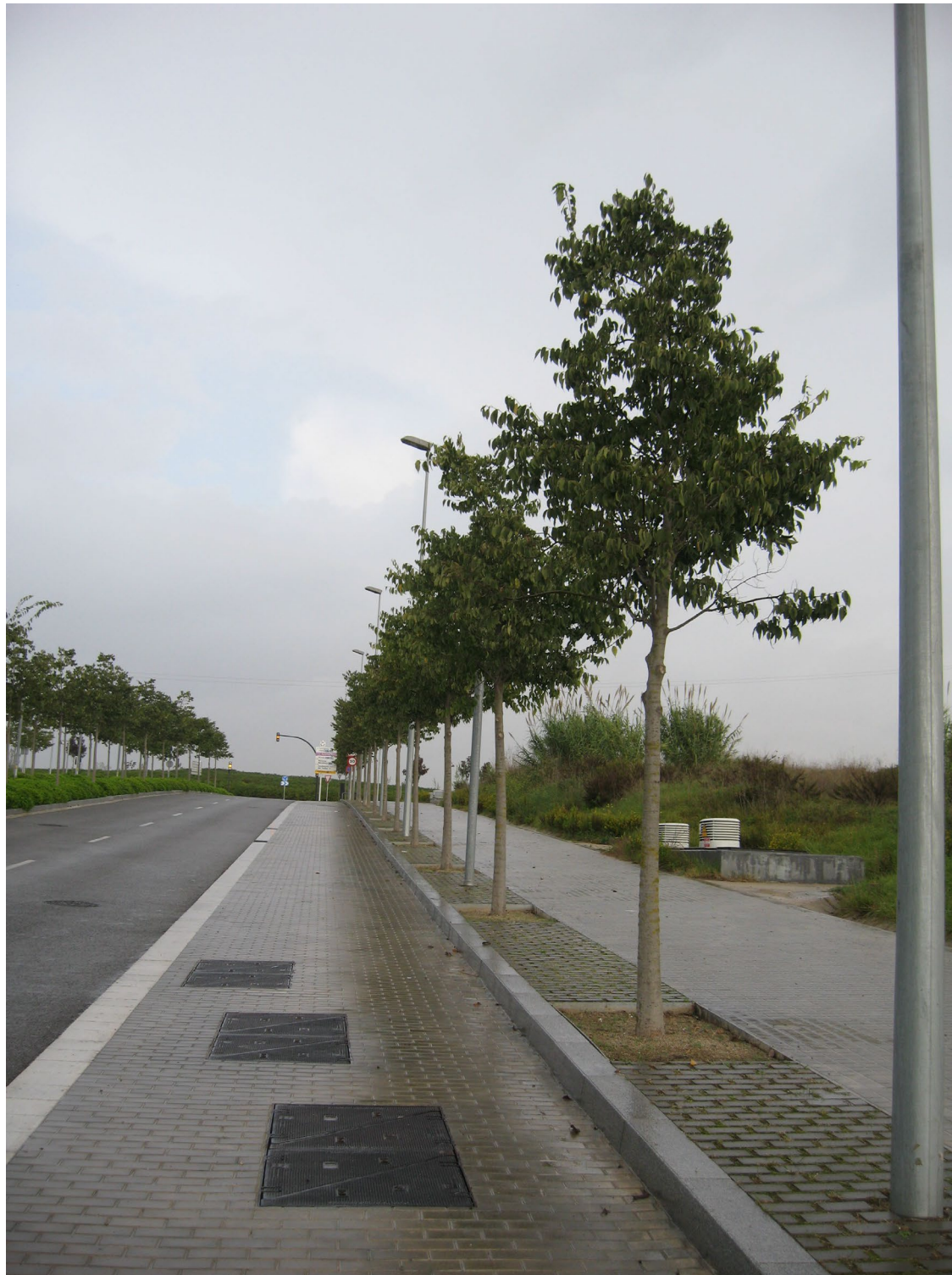
Vorera de l'Avinguda de la Ciència amb alineació de lledoners i escossell corregut de panot via verda.
