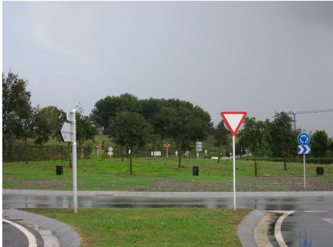
Rotonda de la BP-1413 amb bosquetó de roures al centre. 1era fase d'execució del Parc de l'Alba
