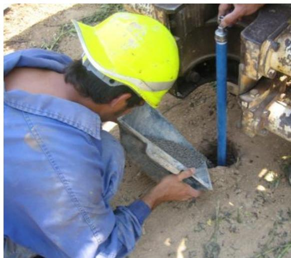
Figura 2.5. Piezòmetre de mesura se sòl gas en SG-18 a) Detall b) Rebliment bentonita final
