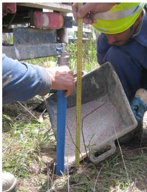
**Introducció de la graveta silícia calibrada de diàmetre 2-4mm, rodada i rentada a la zona de tuberia ranurada del SG-18**
