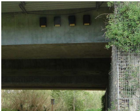
Viaducte del torrent del Bosc
