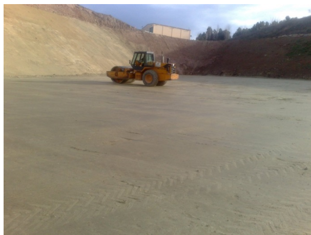
Il·lustració 4 estat que ha de tenir la superfície d'argiles abans de la col·locació de la làmina PEAD
