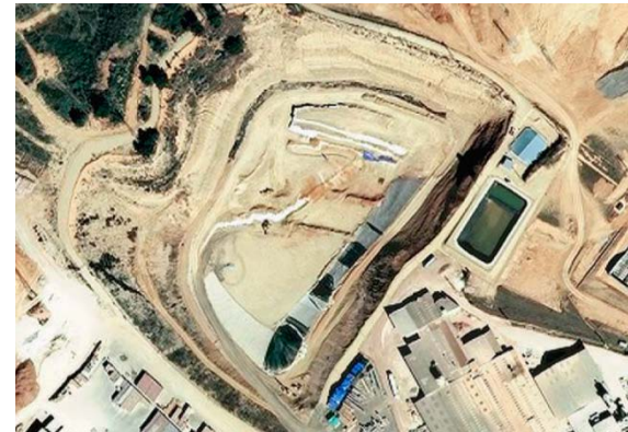
Il·lustració 11 Ortoimatge de l'ICC de l'any 2008. Es detecta per primera vegada la presència de làmines per la impermeabilització del vas.
