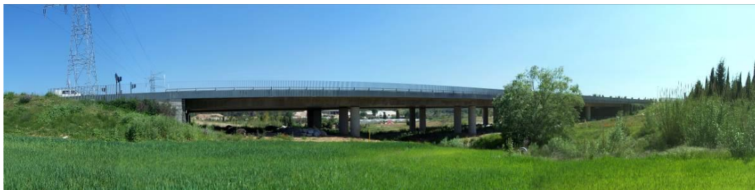
Restitució de la llera del torrent de Can Fatjó
