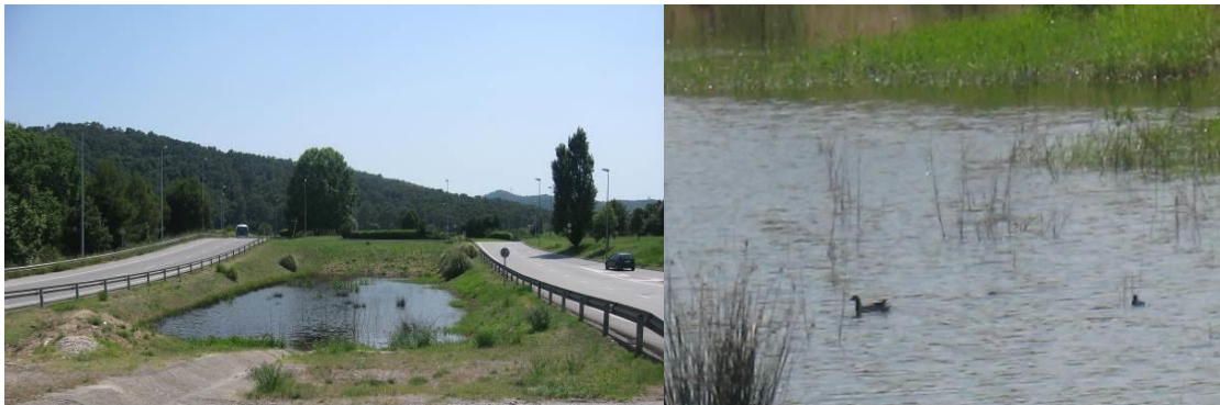
Laminació natural de les aigües de pluja existent en un enllaç de carreteres a Cerdanyola
