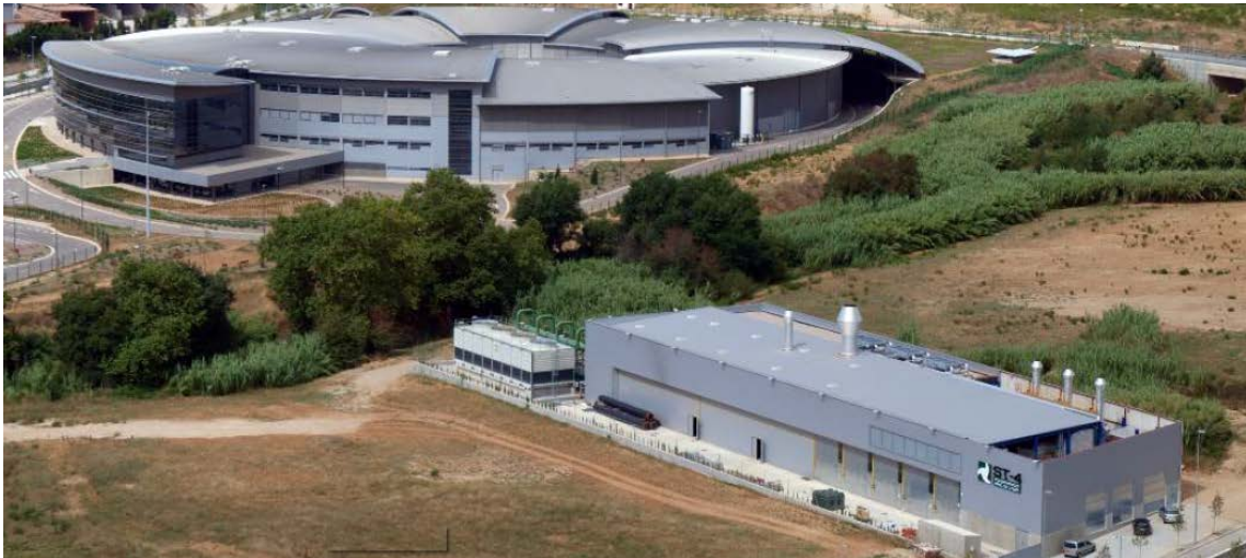
Vista aèria de la planta de poligeneració ST4 i el Síncrotró Alba
