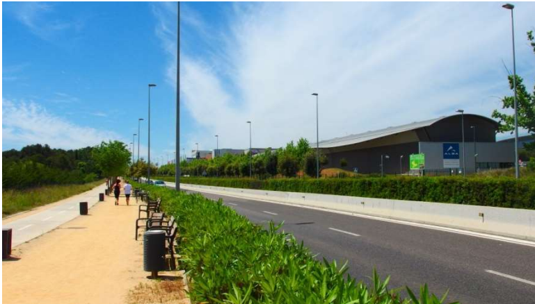
Vista actual de la Carretera BP-1413
